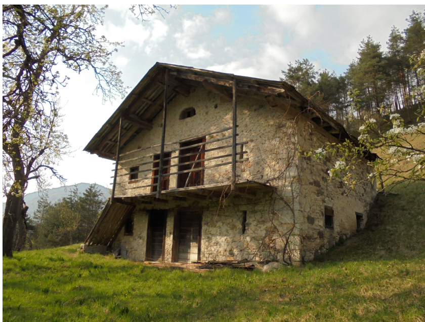
Fabbricato rurale soggetto a conservazione tipologica destinato a stalla e fienile
